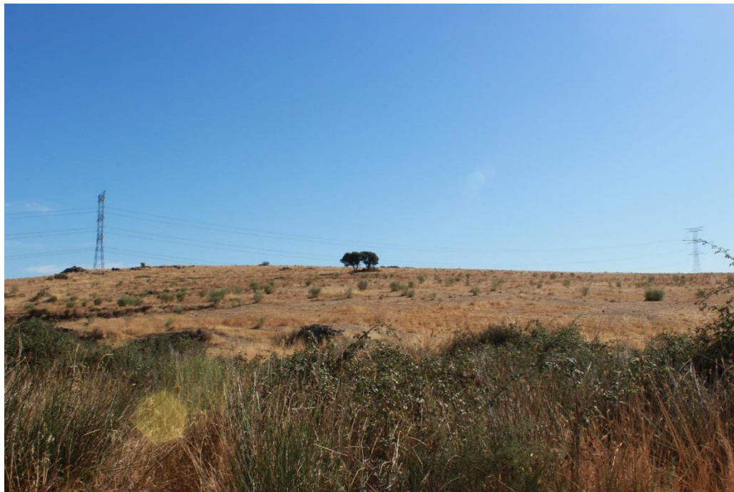
Figura 8. Tendido eléctrico en el entorno de la zona.
